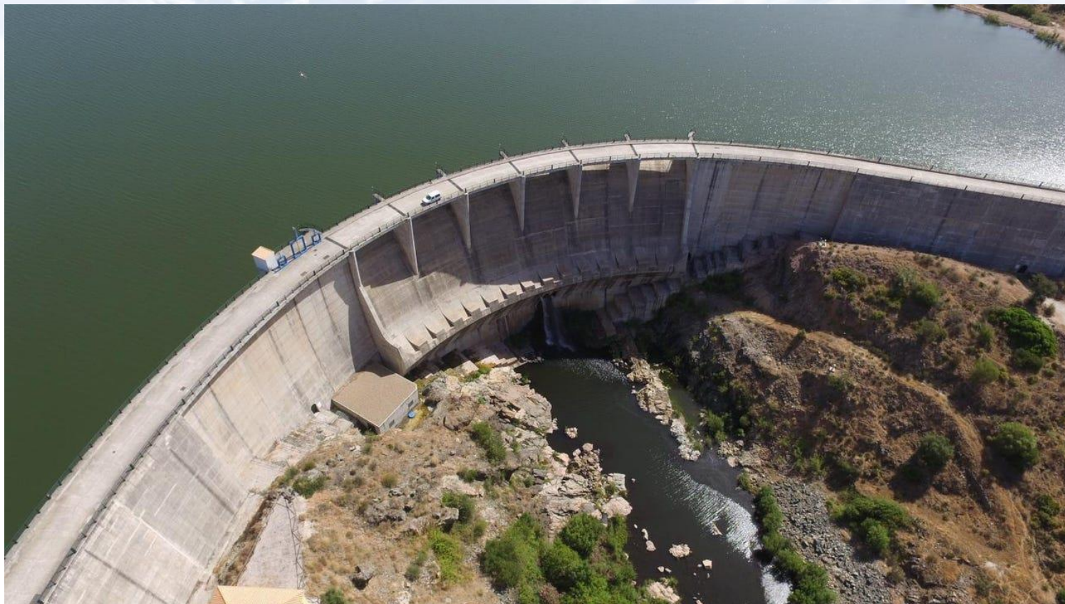
Presa de arco-gravedad. Melonares, río Aviar (Sevilla)
