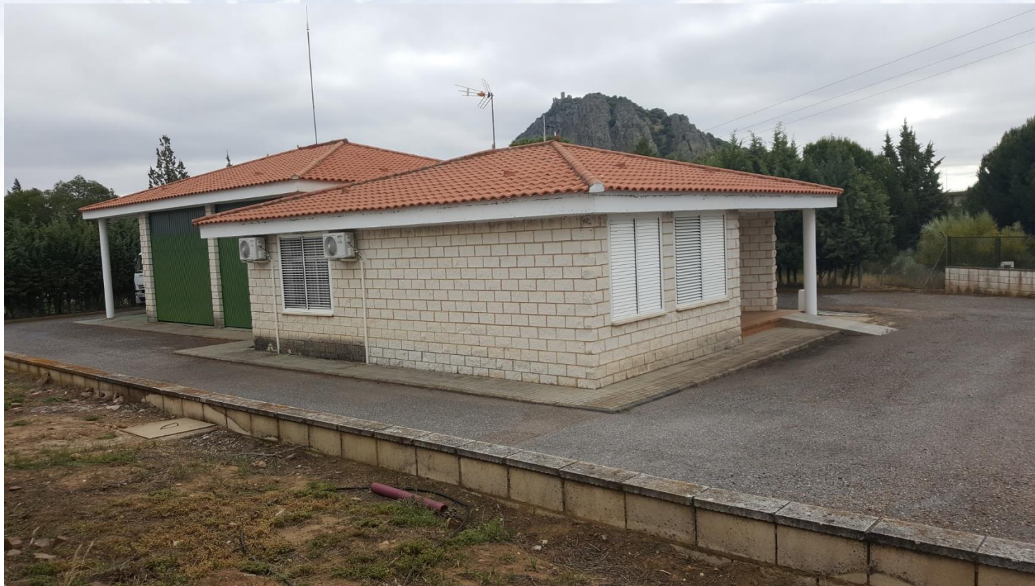
Sala de emergencia presa de Alange
