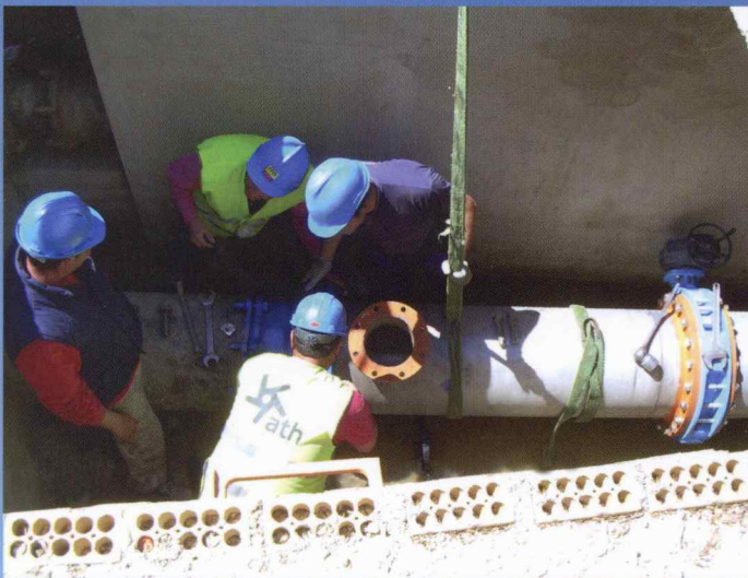
URI 1 INSTALACIÓN DE CALDERERÍA Y VALVULERÍA
