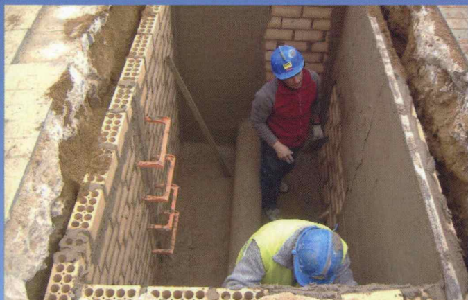
ARQUETA MUROS DE LADRILLOS Y ENFOSCADO
