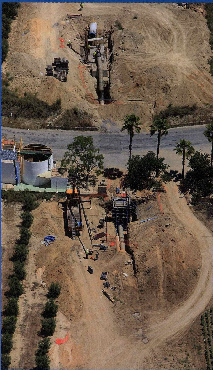
HINCA EN ARQUETA DE BEAS
