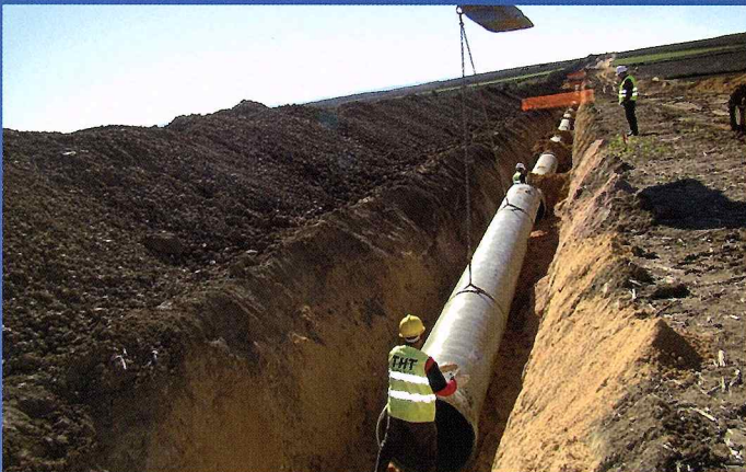
INSTALACIÓN TRAMO PRFV ZONA RURAL
