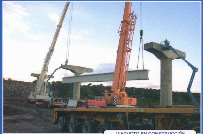
VIADUCTO EN CONSTRUCCIÓN
