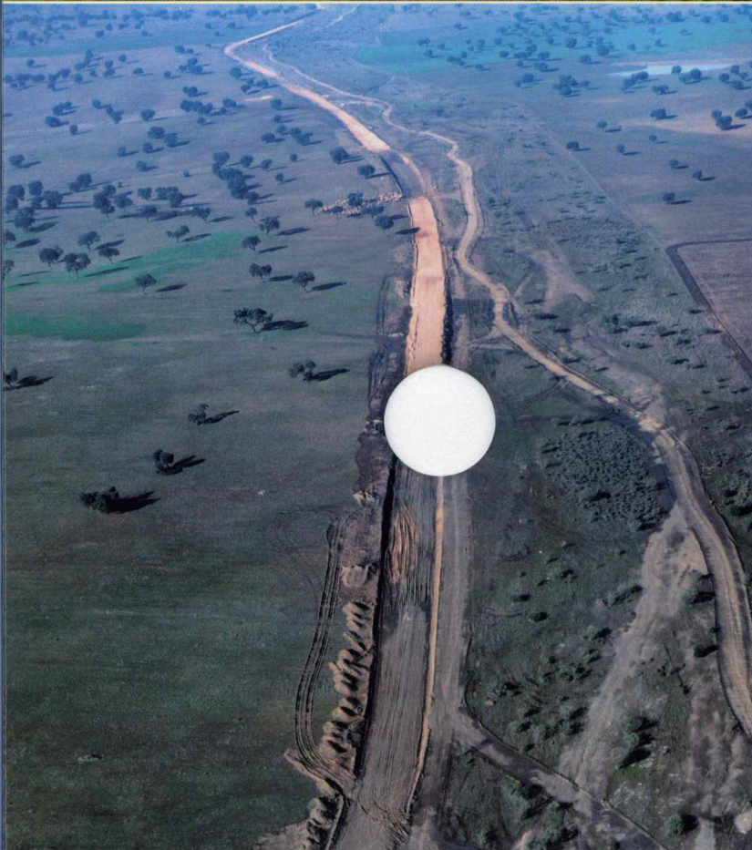
CARRETERA DE ACCESO A LA PRESA
