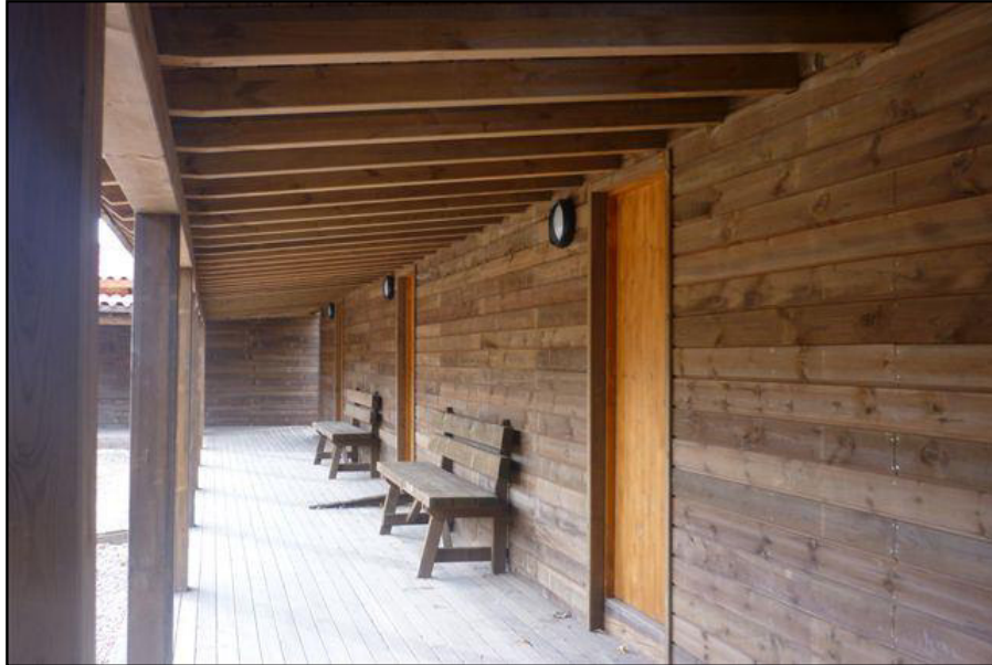
Porche exterior zona cabañas
