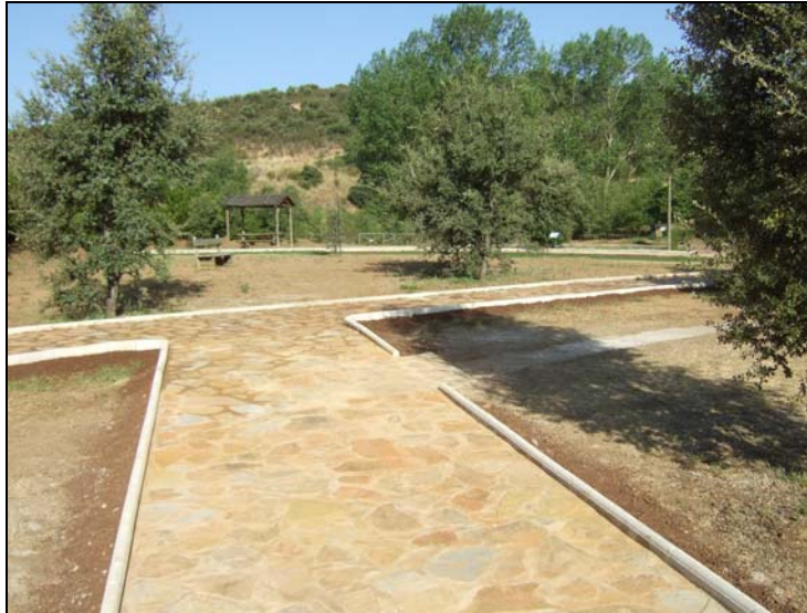
Acondicionamiento de la red de senderos mediante la mejora de la accesibilidad para personas con movilidad reducida en el Centro de interpretación del PN Cabañeros
