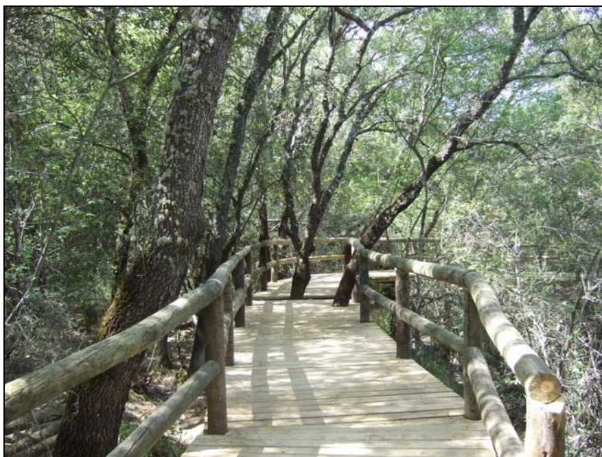
Continuación de la pasarela de madera autoguiada en el PN Cabañeros, que forma parte de la red de senderos del Centro de Interpretación Torre de Abraham
