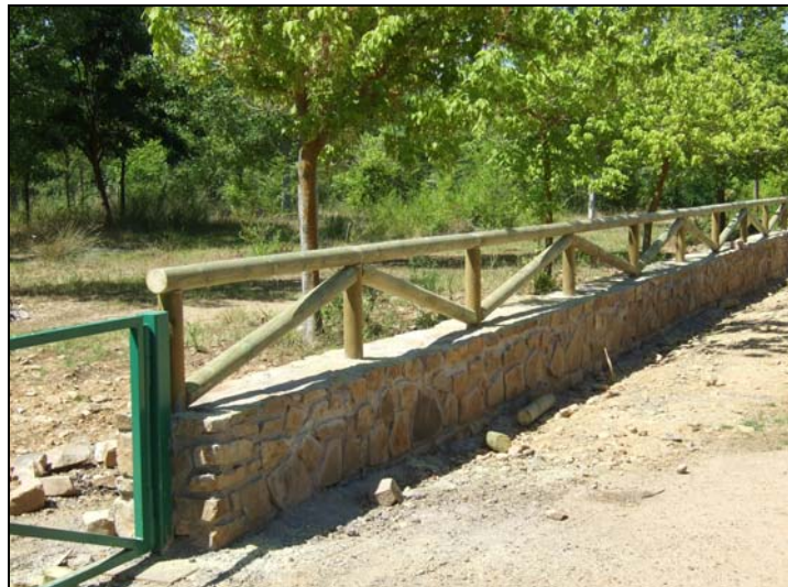
Cerramiento en el área recreativa de El Torno para evitar el paso de vehículos a las zonas no autorizadas.
