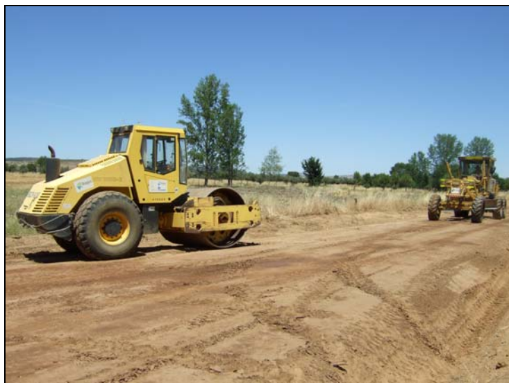
Acondicionamiento de un tramo del camino que formará parte del Sendero del Bullaque
