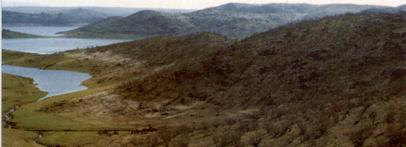
Boca Zújar. Situación antes de la obra
