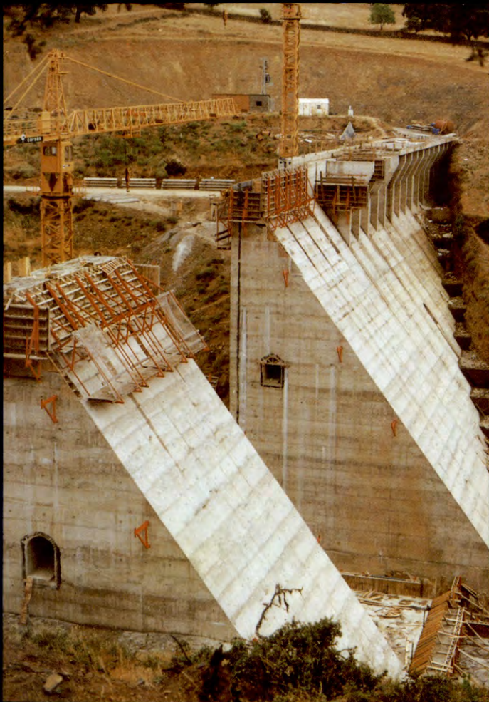
Presas en construcción.
