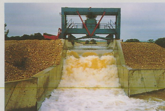
Obra de entrega en Canal Dehesas. Enero 1997.
