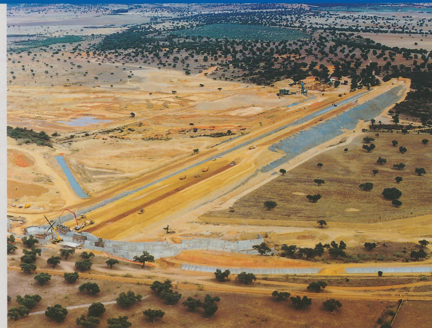
Presa en construcción. Septiembre 1995.
