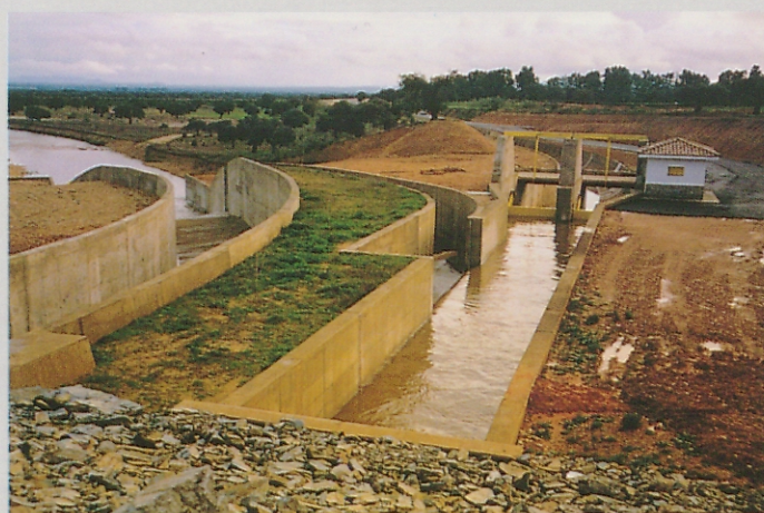
Grupo compuertas y aliviadero lateral. Enero 1997.
