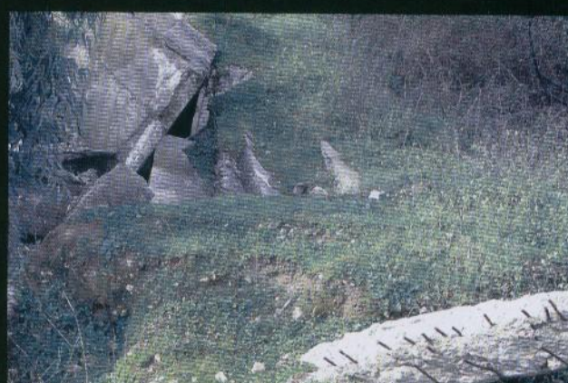
■ Restos de obras de fábrica en los márgenes del río Guadiana (Badajoz)
