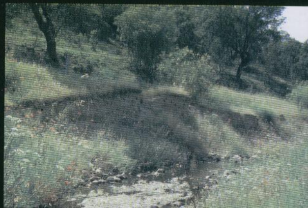
■ Orillas erosionadas en el río Guadalmez (Córdoba)
