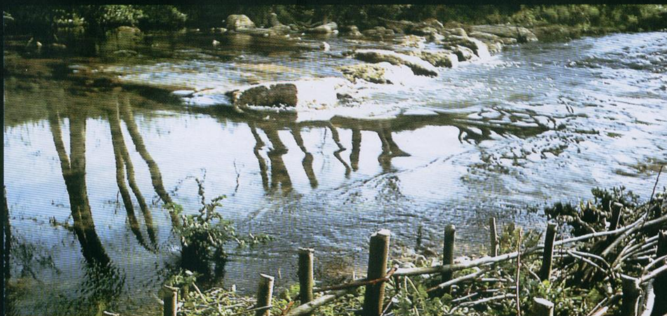
Encañizados en primera plana y deflectores al fondo en el río Gévora (Badajoz) ■
