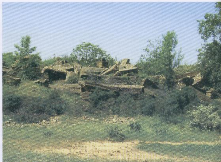
■ Gabiones en el río Bullaque (Ciudad Real)
