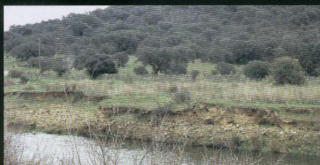
Problemas de erosión en el río Aljucén (Cáceres)
