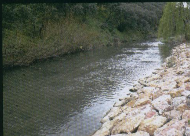
■ Fajinas y escolleras en el río Guadalemar (Badajoz)
