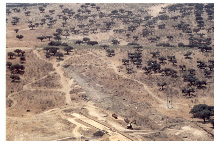
EXCAVACION DE CIMIENTOS
