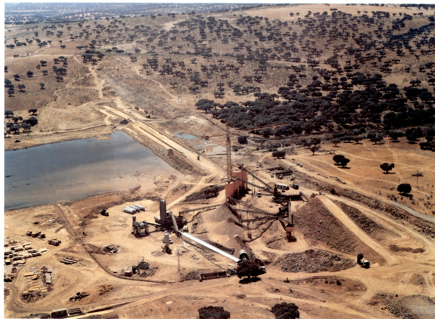
PRESA EN CONSTRUCCION
