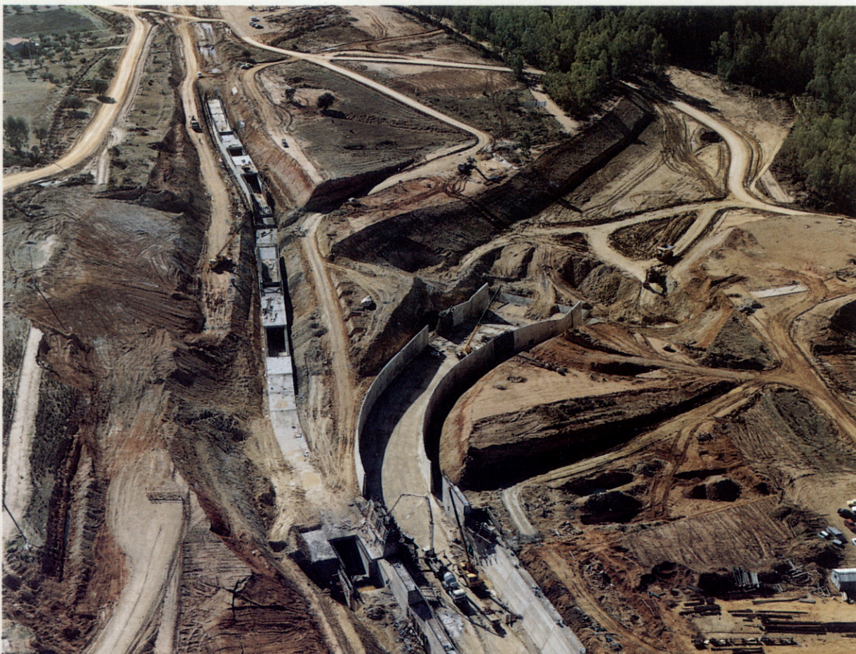
Construcción del aliviadero y canal de salida. Noviembre 1994
