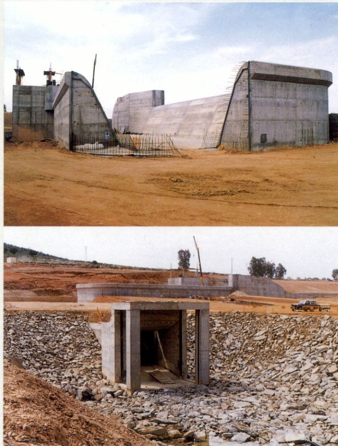
Aliviadero y obra de toma. Mayo 1995.
