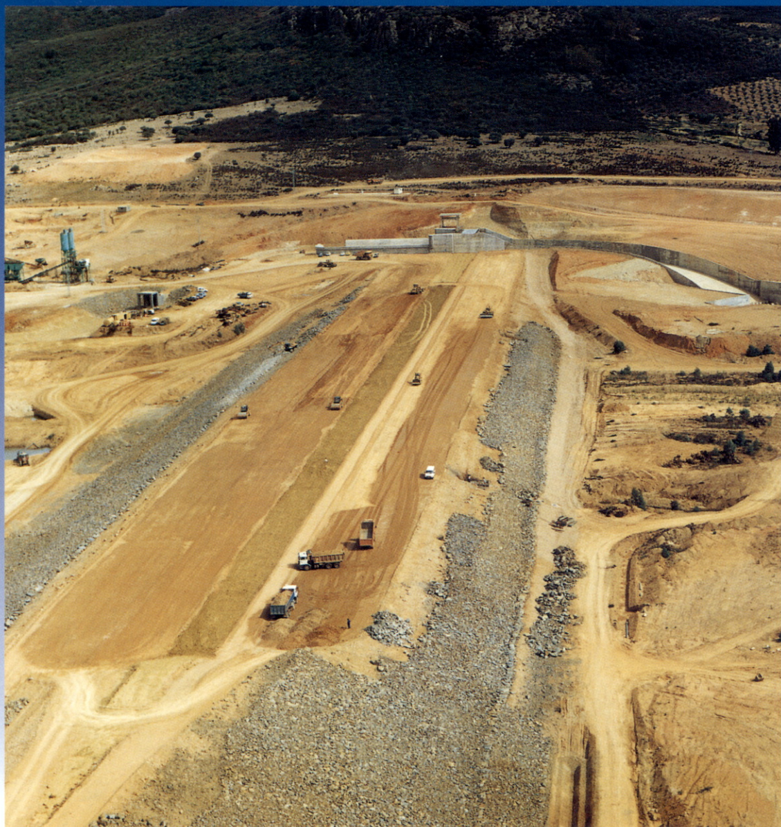
Presa en construcción. Septiembre 1995.
