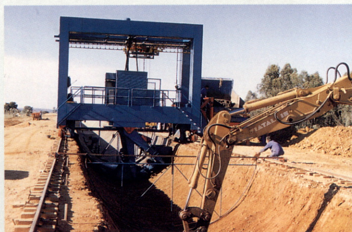
Revestimiento del canal. Febrero 1995.
