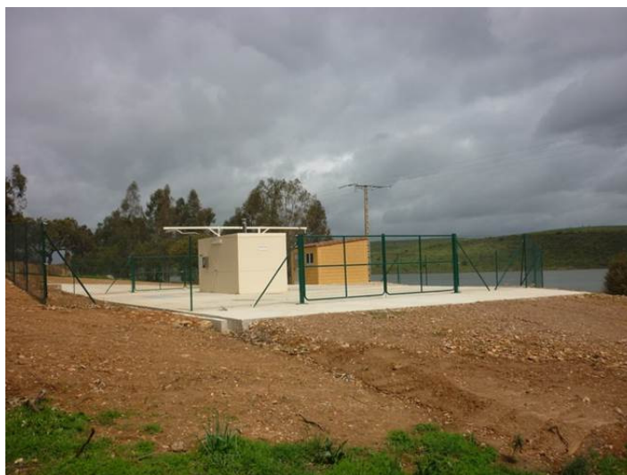
Ilustración 12. Estación Fija de desinfección de embarcaciones de la Confederación Hidrográfica del Guadiana 1. Fuente: Confederación Hidrográfica del Guadiana.
