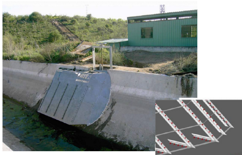
Ilustración 25. Detalle del sistema de limpieza del sistema de filtración, instalado en la cara inferior del filtro. Fuente: Filtros Palacios, S.L.
