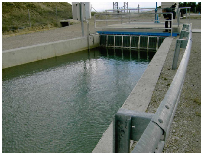
Ilustración 26. Filtro para final de canal. Fuente: Filtros Palacios, S.L.
