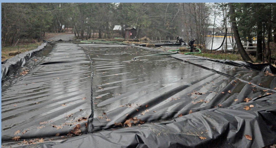
Ilustración 6. Imágenes del proceso de succión para la eliminación de la almeja asiática. Arriba se observa el sistema de bombeo sobre una pequeña embarcación neumática. Abajo puede observarse las parcelas de geotextiles permeables donde se depositan los residuos de la succión (almejas, sedimento y agua) para, posteriormente, retirarlos a un vertedero autorizado. Fuente: Lake George Asian Clam eradication Project
