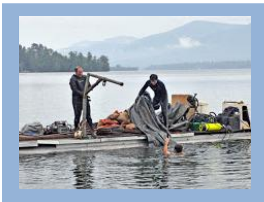
Ilustración 14. Operaciones de retirada de mantas. Fuente: Lake George Asian Clam Eradication Project http://www.stoptheasianclam.info/ .
