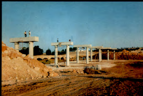
PUENTE EN CONSTRUCCION
