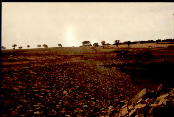
PARAMENTO AGUAS ARRIBA (ESCOLLERA)
