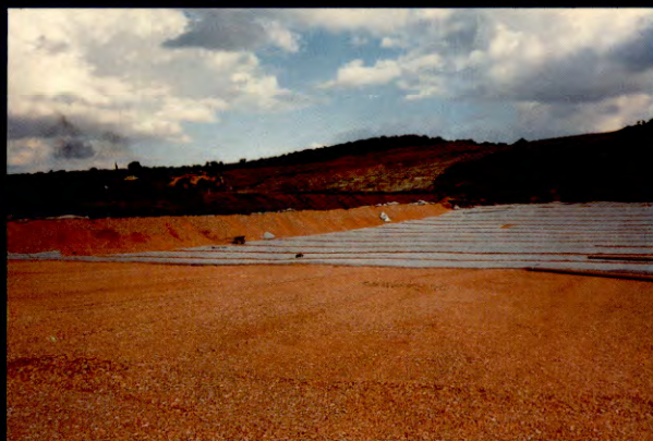
CONSTRUCCION DEL FILTRO
