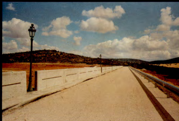
CORONACION DE PRESA
