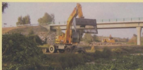
Daños en infraestructuras
