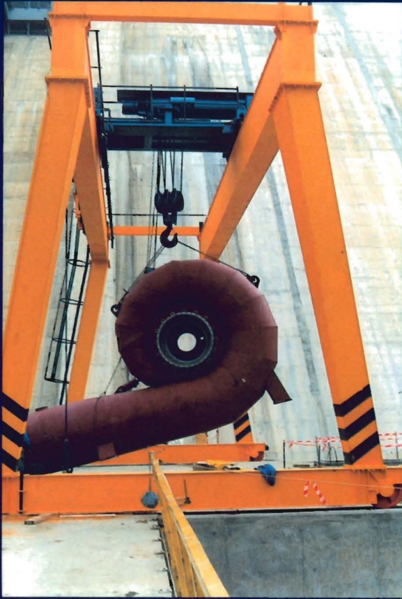
Colocación de la turbina por el puente grúa.
