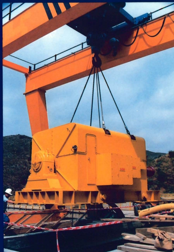
Colocación del grupo generador.
