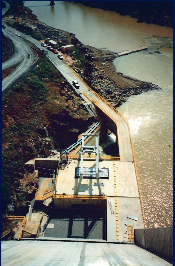
Vista de la Central desde la coronación de la presa.
