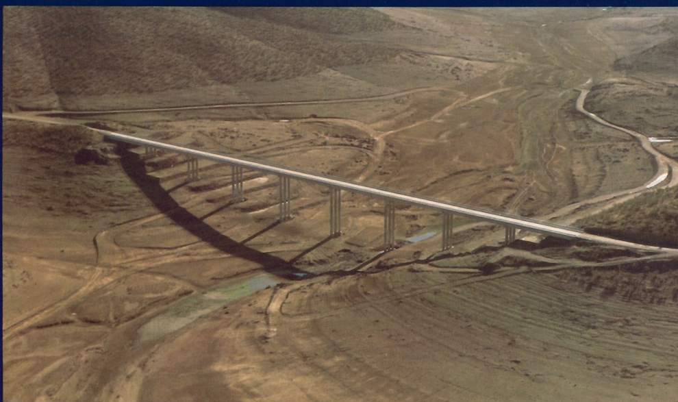
Viaducto del Almorchón
