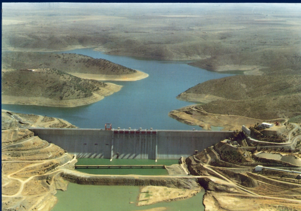
Presa aguas abajo
