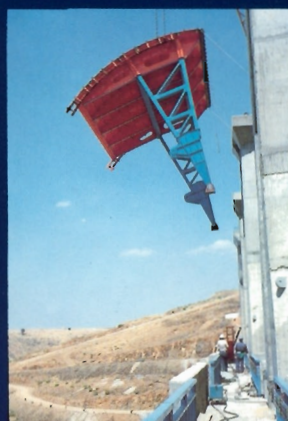
Montaje compuertas Taintor
