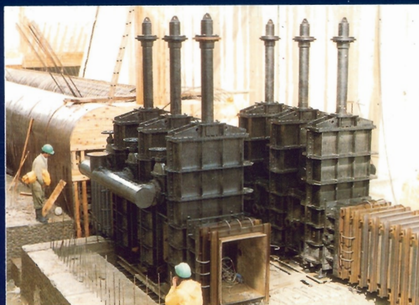
Instalación válvulas desagüe de fondo
