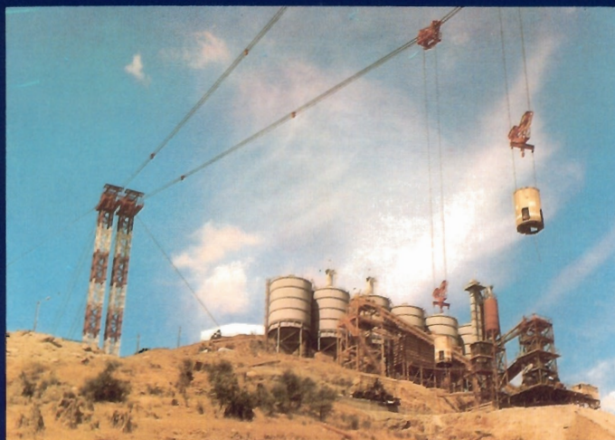
Planta de hormigonado, silos de aglomerantes y torres de blondines
