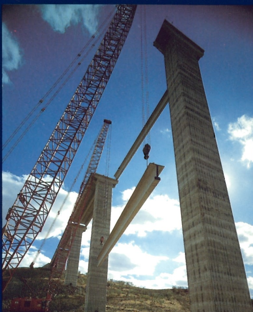
Viaducto en construcción
