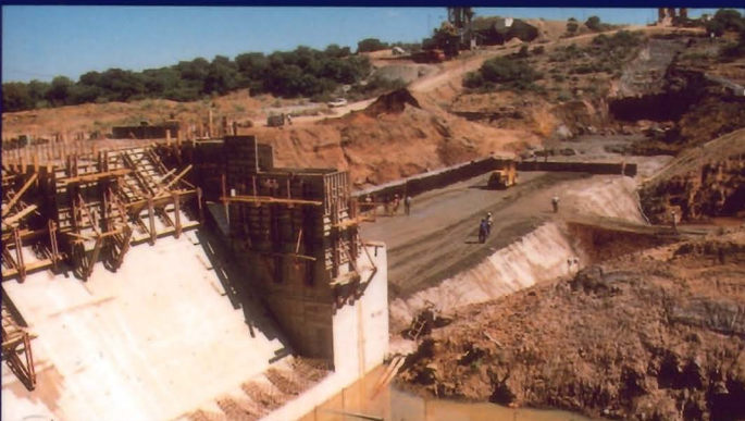
Compactación hormigón con rodillo vibratorio.
