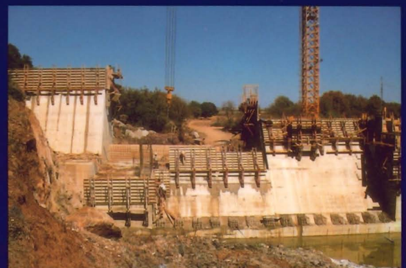
Vista aguas abajo del aliviadero.
