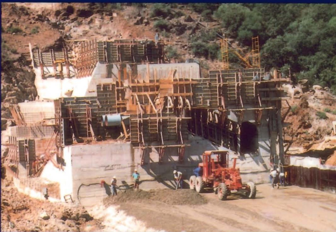
Enlace aliviadero-hormigón compactado.
