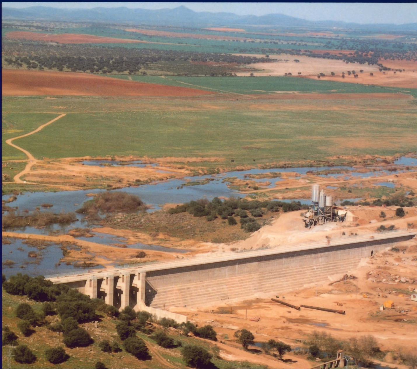
PRESA DE LOS CANCHALES
