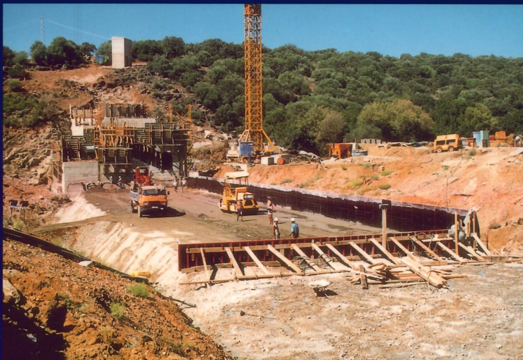
Zona de hormigón compactado, en construcción.
