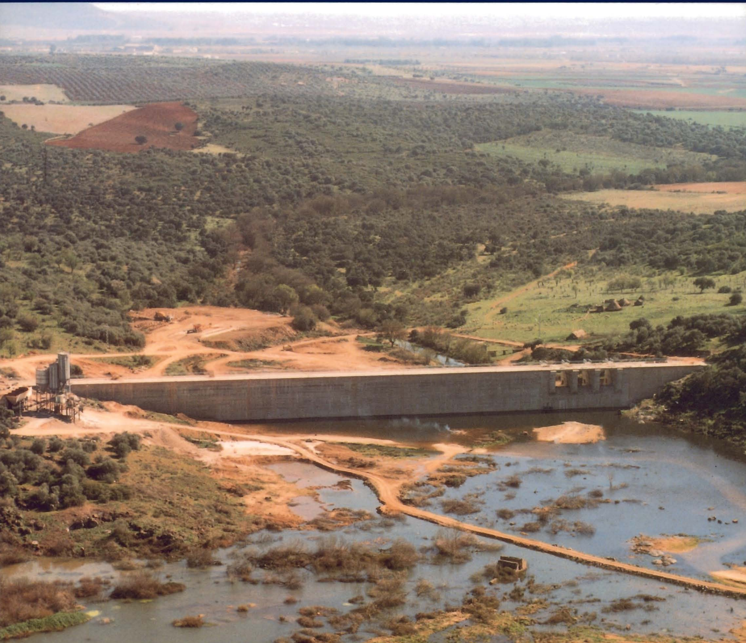
Panorámica aguas arriba.
