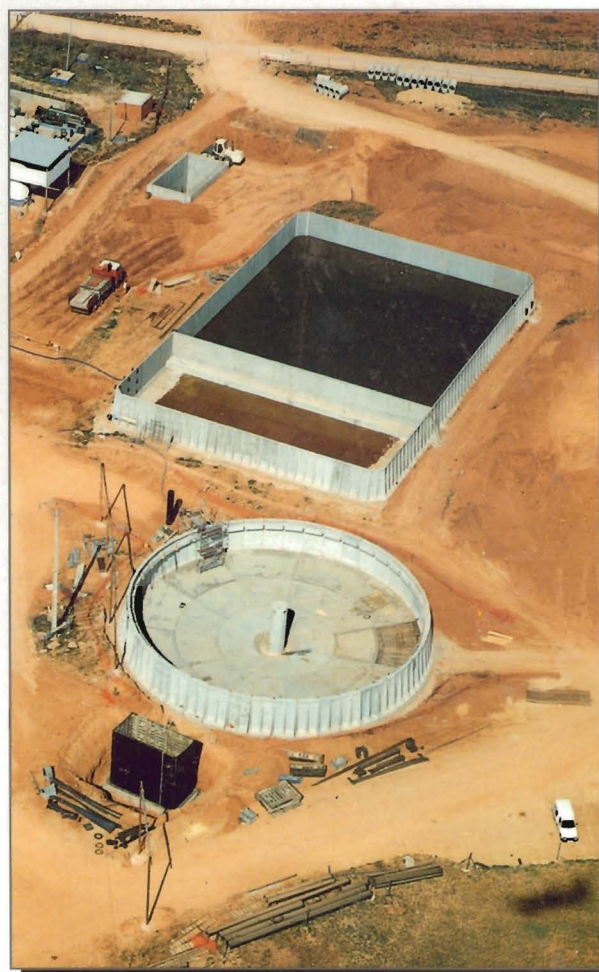
BALSA DE HOMOGENEIZACIÓN Y DECANTADOR PRIMARIO
