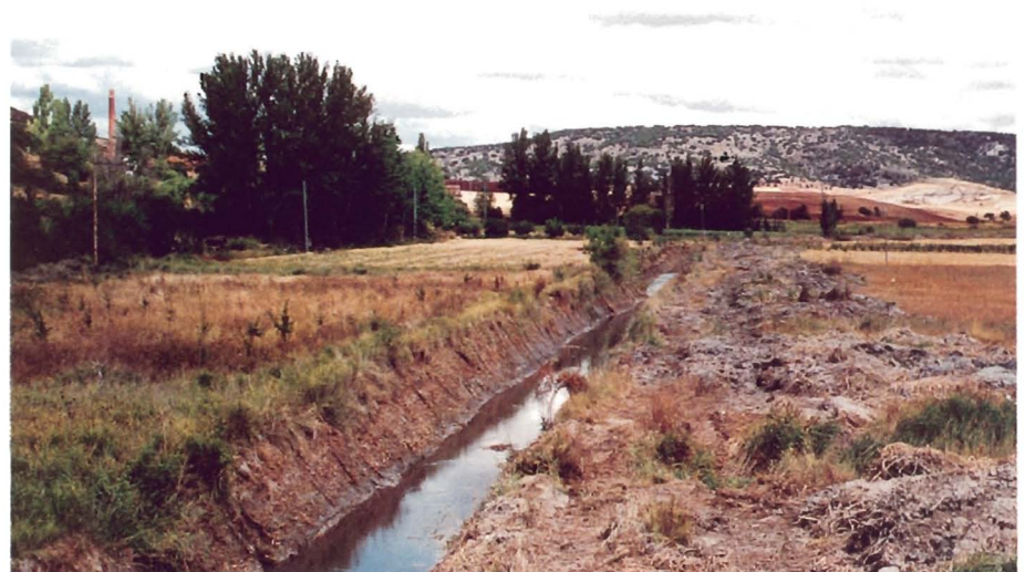
Limpieza y acondicionamiento del cauce del río Henares
