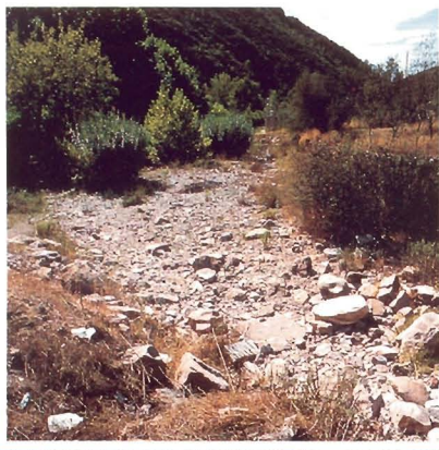
Acondicionamiento del cauce del río Zamba del Cañar y Bco. de la Forquia en un tramo de 200 m.
