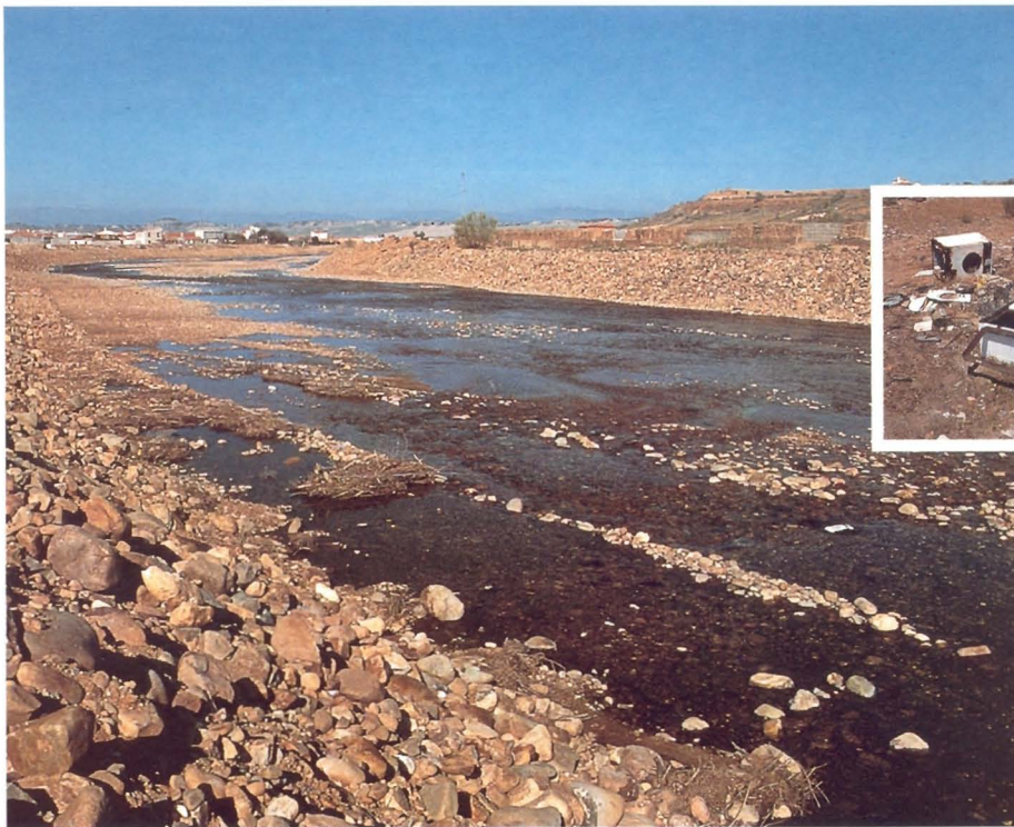
Limpieza y acondicionamiento del cauce del río Gevalo en un tramo de 2.160 m.
