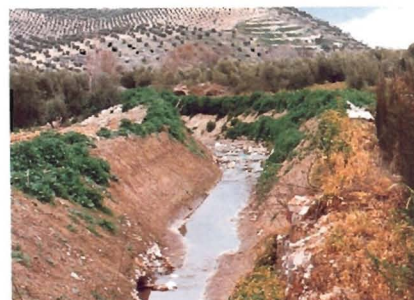
Acondicionamiento del cauce del arroyo La Tejera en Almodóvar del Río
