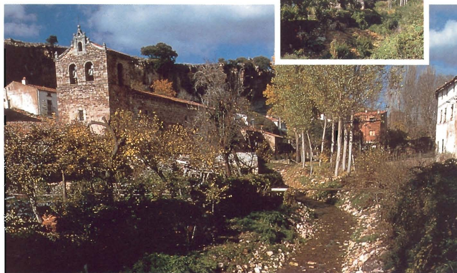
Limpieza y acondicionamiento del cauce del río Tajuña en un tramo de 1.100 m.
