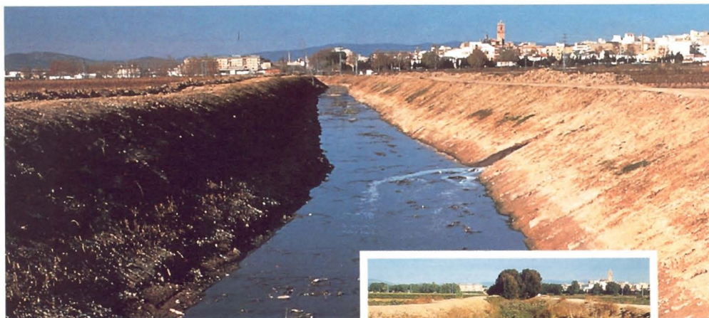
Limpieza, regulación y acondicionamiento del cauce del río Magro en un tramo de 3.300 m.
